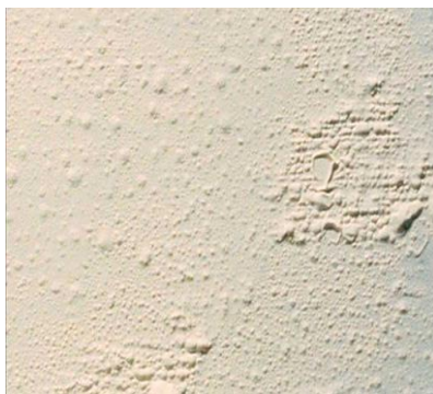
Рис. 4. Дефекты защитно-отделочного покрытия: а – шелушение; б – пузырьки на окрасочном покрытии
