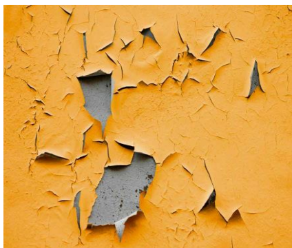
Рис. 4. Дефекты защитно-отделочного покрытия: а – шелушение; б – пузырьки на окрасочном покрытии
