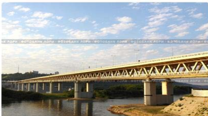
Рисунок 1 – Общий вид моста.
