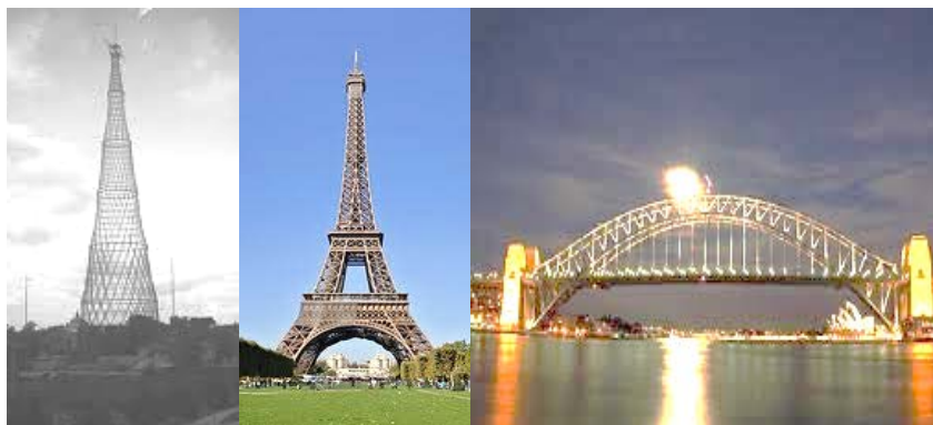
Рисунок 2 – Сооружения возведённые при помощи заклёпок
