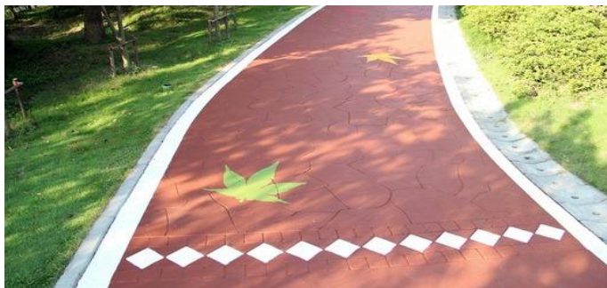
Рис. 1. Участок дороги с асфальтобетонным покрытием красного цвета
