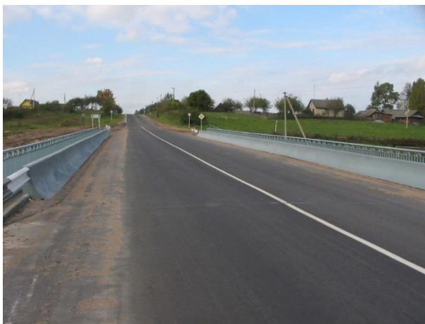
Рис. 3. Мостовое полотно после капитального ремонта
