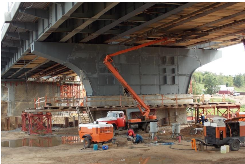
Рис. 6. Вид на металлическую обстройку опоры №4. 17.05.2016
