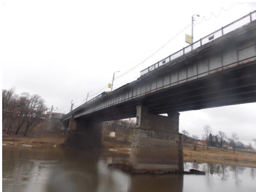
Рис. 1. Общий вид моста до ремонта (русловые пролеты и опора №4)
