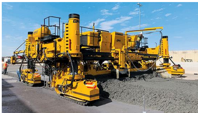
Рис. 6. Бетоноукладчик GOMACO GP4
