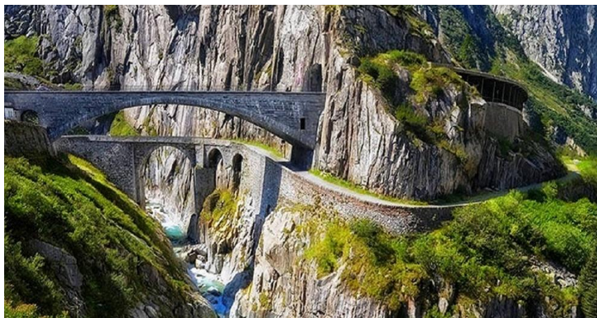
Рис. 3. Внешний вид моста Тейфельсбрюкке
