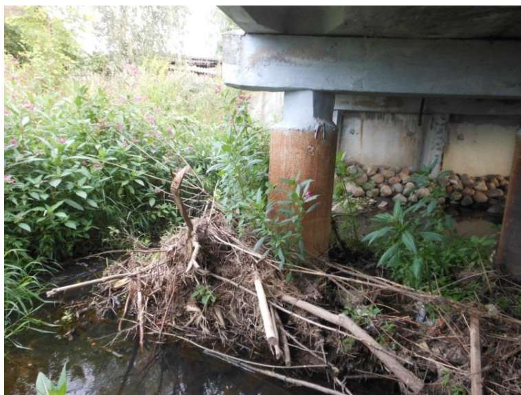
Рис. 6. Восстановление ж.б. свай с использованием стальной обоймы
