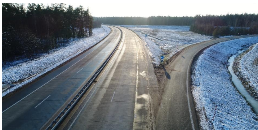
Рис.2. Фото с участка М-3 Минск-Витебск км. 57.3 — км. 65.6 (обход г. Плещицы)
