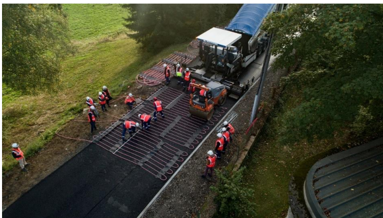
Рис. 2. Строительство автомобильной дороги по проекту Power Road в Эглетоне
