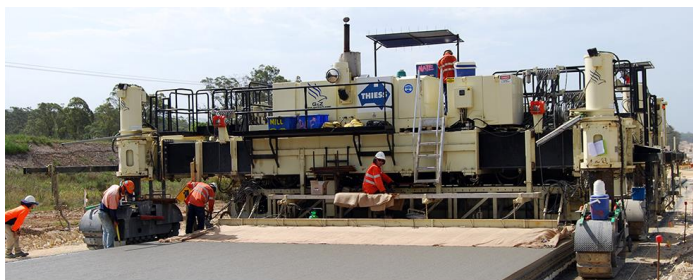
Рис. 2. Бетоноукладчик G&Z S 1500 MULTI-LANE SLIPFORM PAVER
