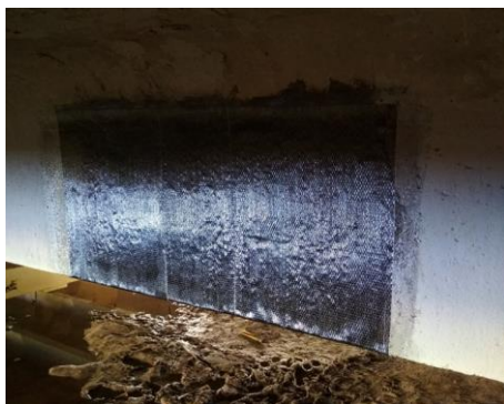
Рис. 4. Локальное армирование балки моста
