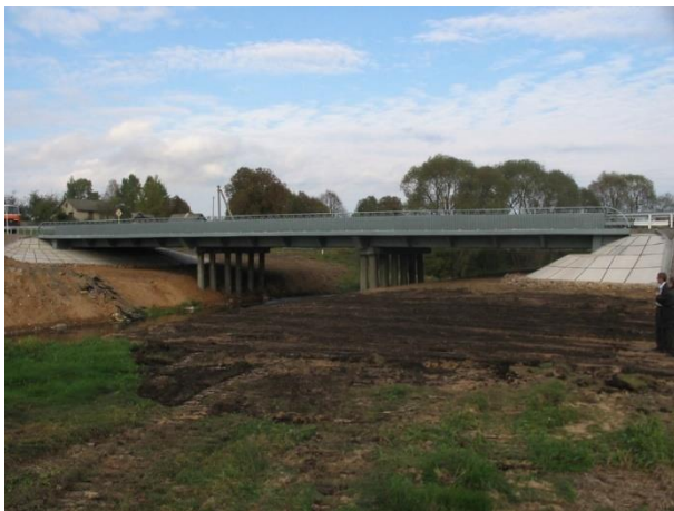
Рис. 2. Общий вид моста после капитального ремонта
