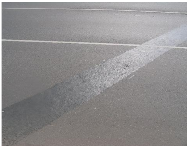
Рис. 2. Движение через «Шов Торма-Джоинт». Темная зона на покрытии - деформационный шов.
