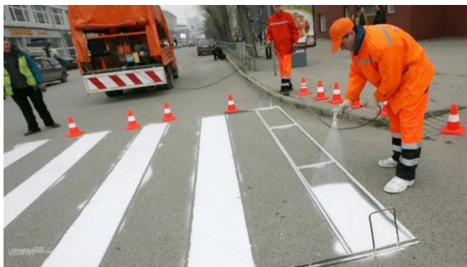
Рис. 3. Нанесение дорожной разметки
