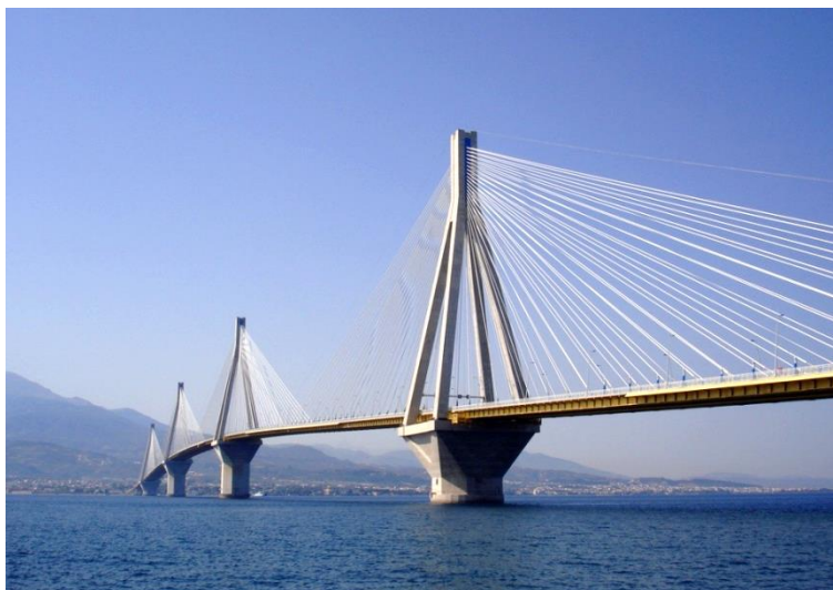
Рисунок 1 – Общий вид моста
