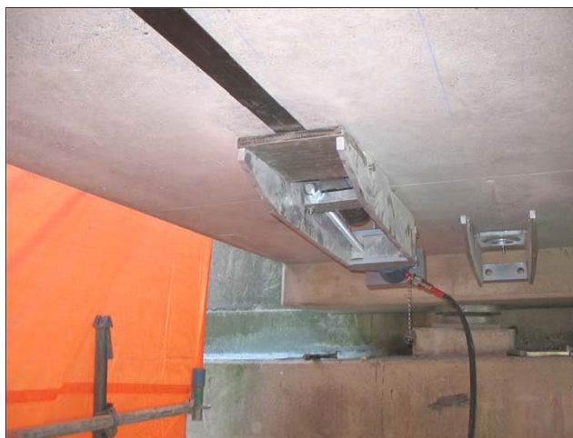
Рисунок 2 – Система для натяжения углеродной ленты
