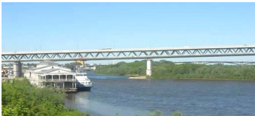
Рисунок 2 – Общий вид моста с другого берега.
