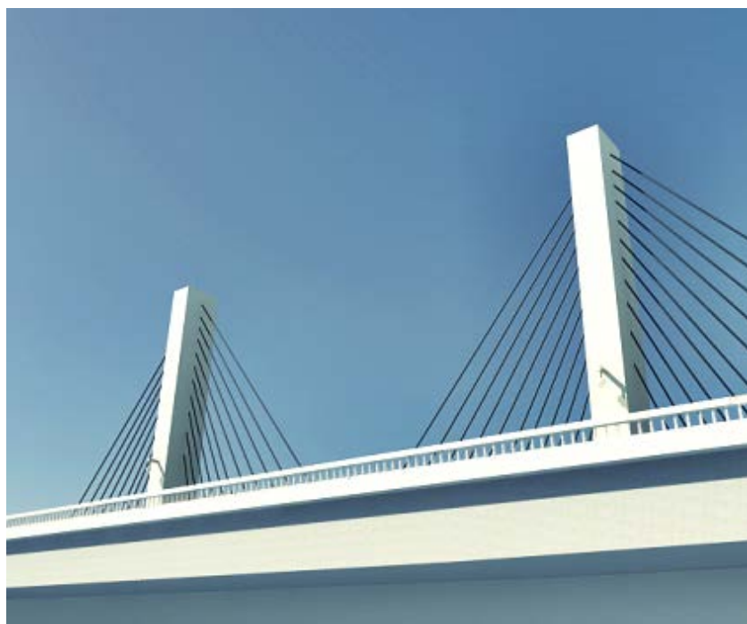
Рисунок 2 – Пилоны сооружения.
