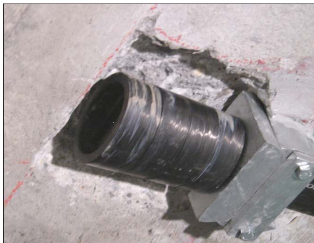
Рисунок 1 – Анкеровка углеродной ленты
