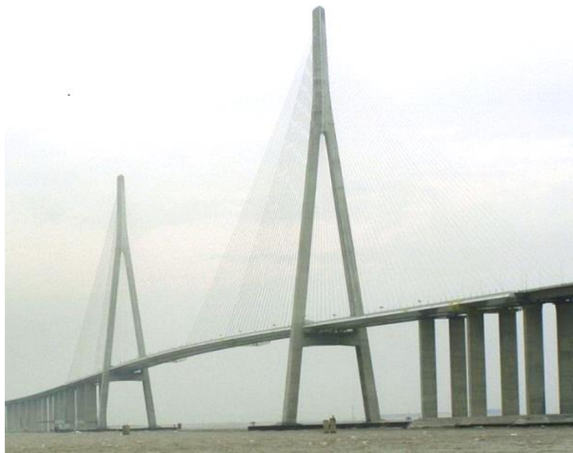
Рисунок 1 – общий вид моста «Сутун».
