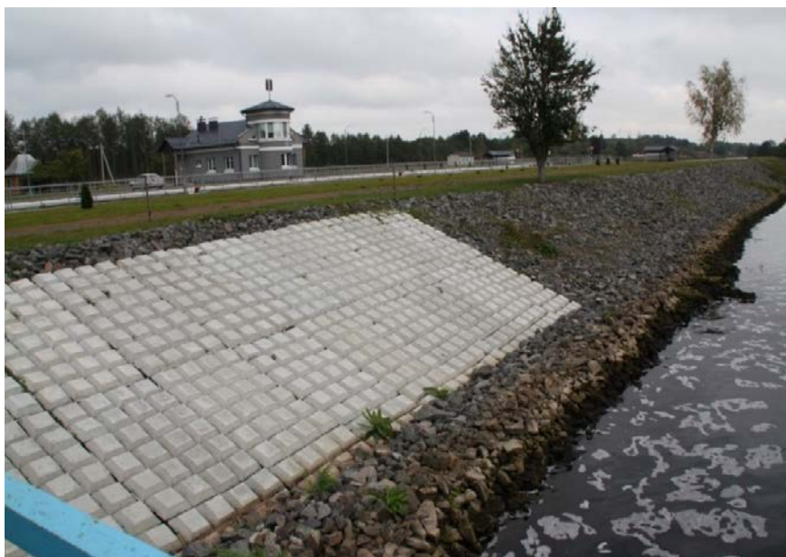
Рис. 6.18. Крепление откоса Днепровско-Бугского канала гибкими бетонными элементами и каменной наброской
