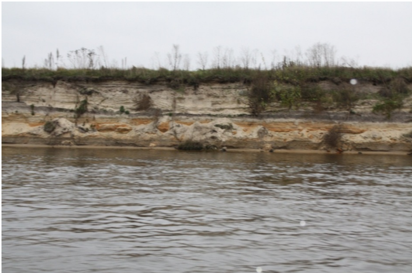
Рис. 3.9. Деформация берега судоходного русла р. Припяти (в районе г. Туров)
