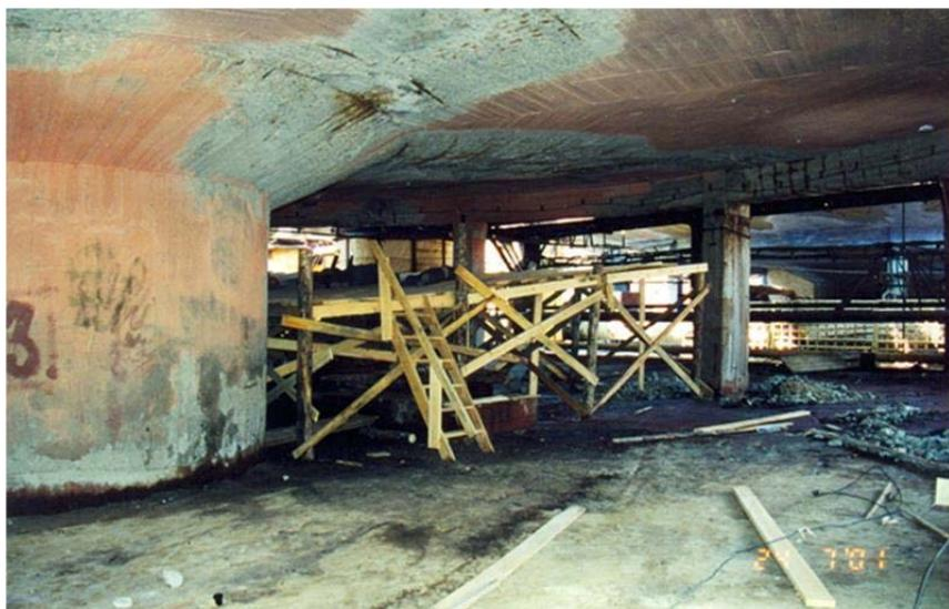
Рис. 7.4. Внешний вид центральной колонны ступителя
