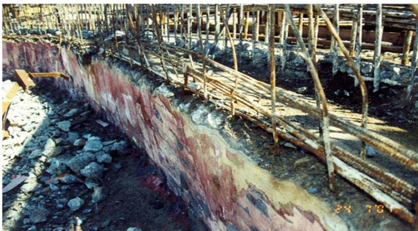
Рис. 7.5. Внешний вид «переливного канала» сгустителя
