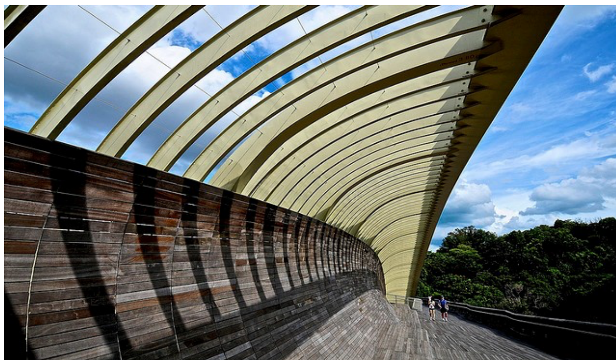
Рисунок 3 – Мост «Волны Хендерсона», вид изнутри
