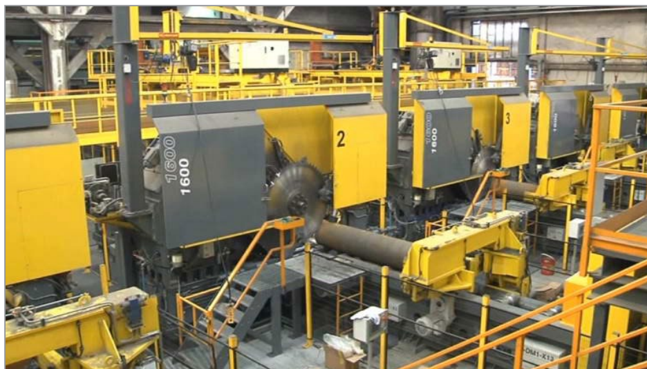
Рис. 4. Участок резки дисковыми пилами на автоматизированной линии для изготовления железнодорожных колес на предприятии Lucchini (Италия)
