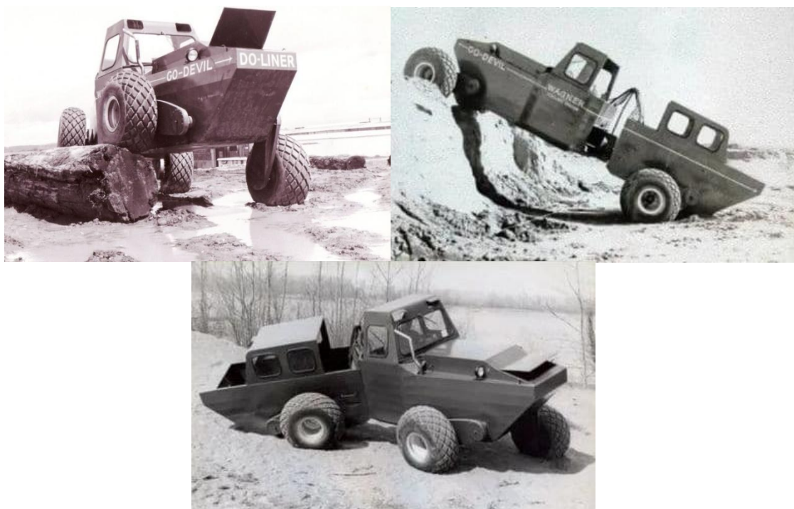
Рис. 1. Колесно-шагающий движитель типа «Го-девилль».
