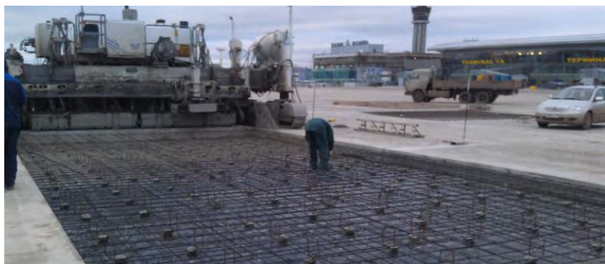
Рис. 1. Пример использования КН арматуры производства ООО НПФ «Уралспекарматура» для армирования перрона аэропорта
