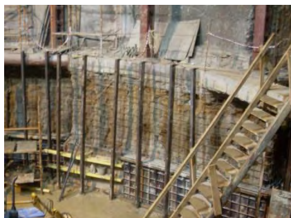
Рис. 5. Выполнение внутри ванны гидроизоляции и облицовки
