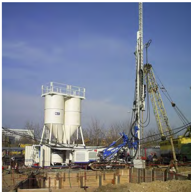
Рис. 1. Оборудование итальянской фирмы Soilmes для струйной технологии
