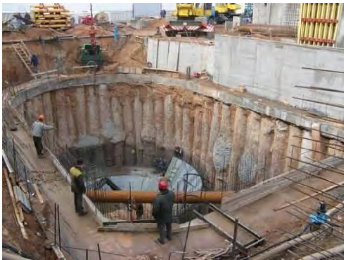
Рис. 11. Ограждение котлована из буронабивных свай диаметром 1,0 м на БАЗ в г. Жлобине
