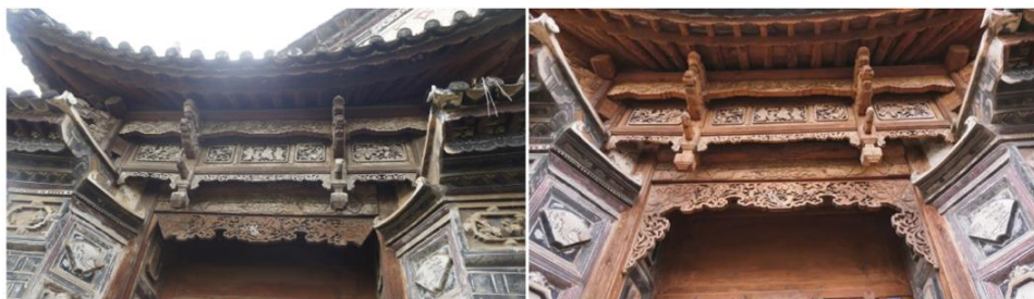
Рис. 2. До и после реставрации традиционных ворот жилого дома
