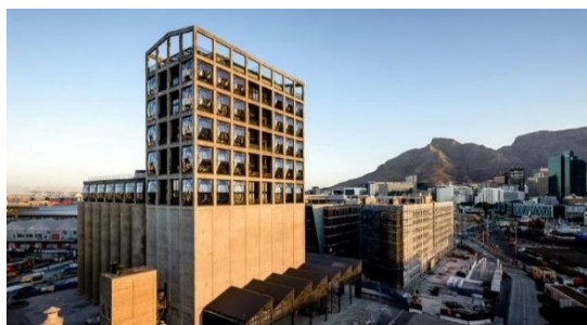
Рис. 2. Перепрофилированное здание зернохранилища в Кейптауне, Южная Африка
