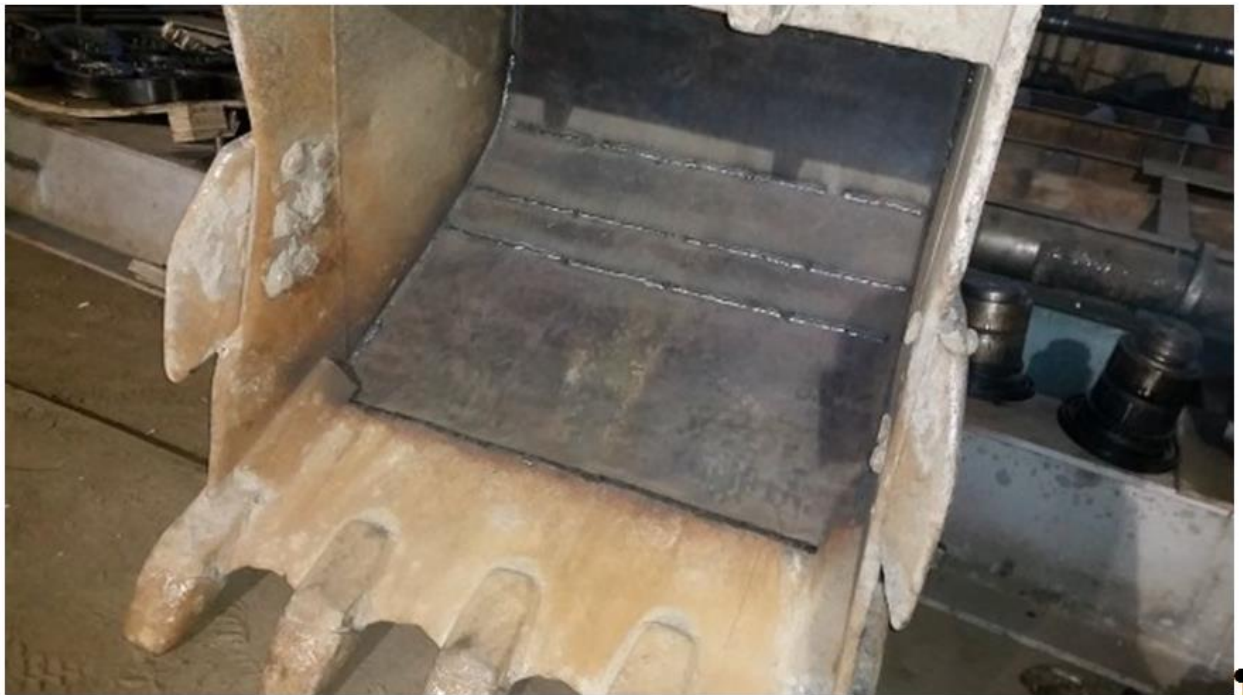
Рисунок 4 – Замена днища ковша при ремонте
