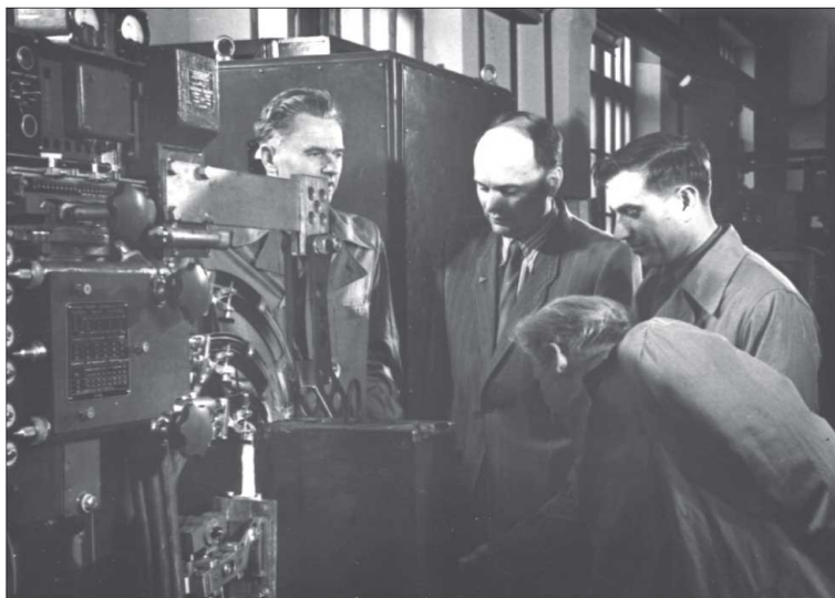
Рис. 2.7. Б. Е. Патон и Г. З. Волошкевич у нового аппарата электрошлаковой сварки
