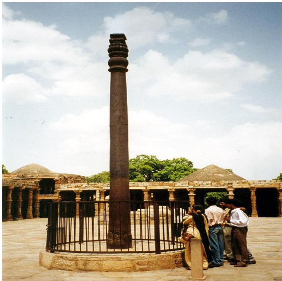
Рис. 2.1. Колонна из кричного железа в Индии
