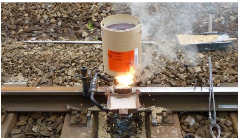
Рис. 2.8. Термитная сварка железнодорожных рельсов
