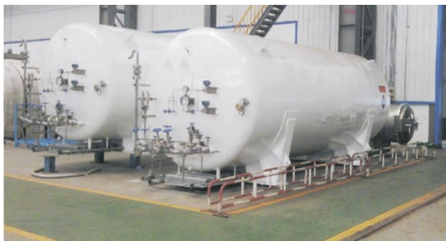
Рисунок 1 – Криогенные резервуары
