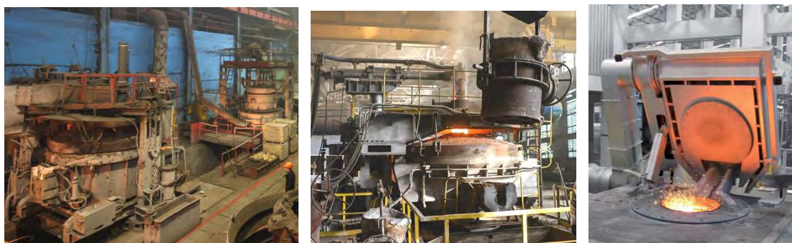
а – электродуговые печи переменного тока ОАО МТЗ емкостью 5 тонн; б – электродуговая печь постоянного тока емкостью 6 тонн ОАО «Бобруйский машиностроительный завод»; в – индукционная электрическая печь емкостью 6 тонн
