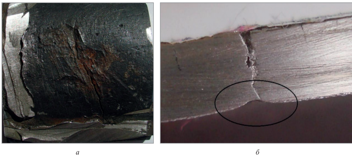
Рис. 2. Сквозное повреждение трубы: а – наружная поверхность стенки трубы, б – поперечное сечение повреждения в зоне трещины на всю толщину стенки трубы, утяжина
