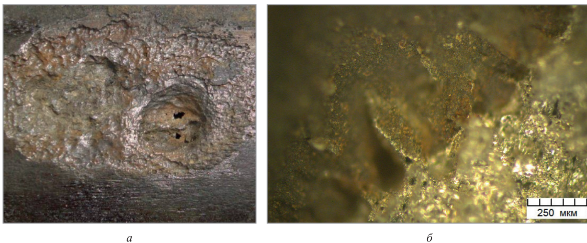
Рис. 3. Участок трубы со сквозным коррозионным повреждением после удаления неметаллических отложений: а – наружная сторона, б – поверхность излома в зоне окисления
