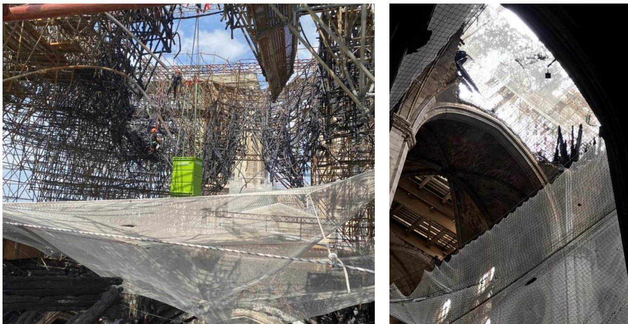
Рисунок 4: а) – связанные веревками рабочие разбирают оплавленные строительные леса; б) – пересечение нефа и трансепта в том виде, в каком оно выглядит сегодня
