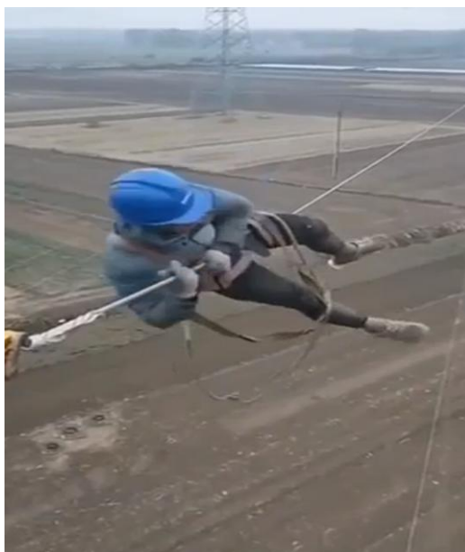
Рис. 4. Основные и наиболее трудоемкие работы в электросетях
