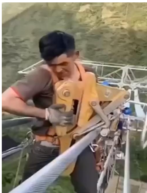
Рис. 6. Основные и наиболее трудоемкие работы в электросетях
