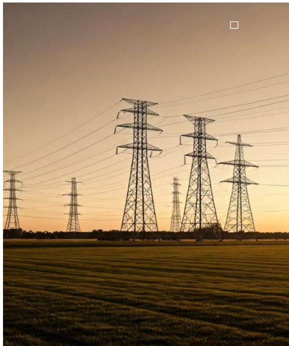
Рис. 1. Воздушные линии электропередач
