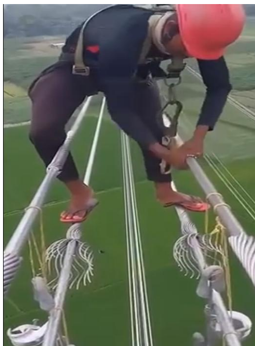
Рис. 2. Основные и наиболее трудоемкие работы в электросетях
