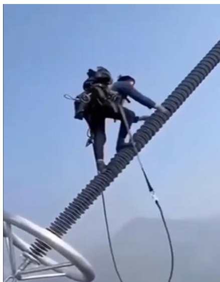
Рис. 3. Основные и наиболее трудоемкие работы в электросетях
