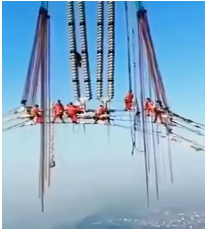
Рис. 1. Воздушные линии электропередач
