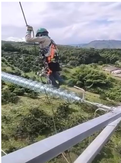
Рис. 5. Основные и наиболее трудоемкие работы в электросетях
