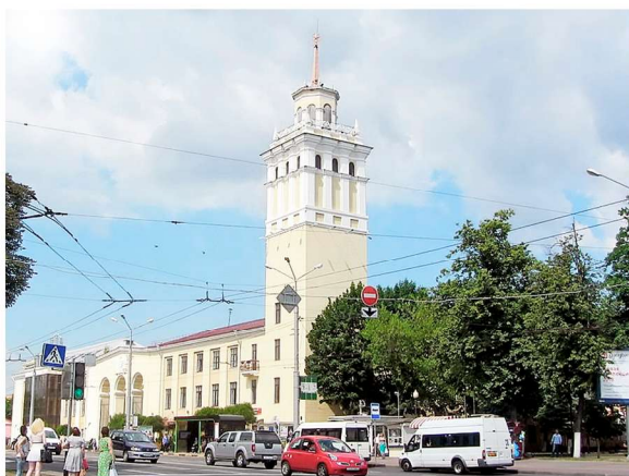
Рис. I. Корпус чулочно-трикотажной фабрики «8 марта» в Гомеле (из открытых источников)
