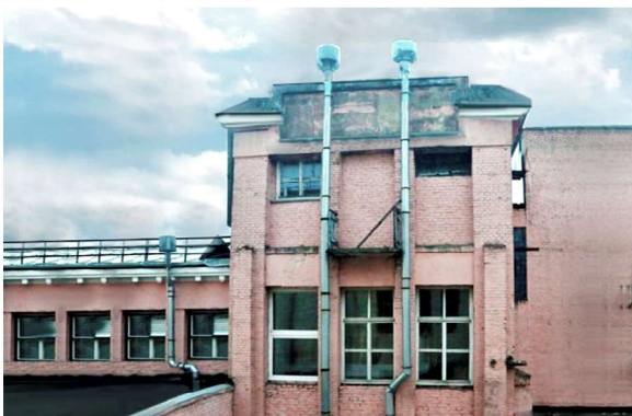
Рис. V. Корпус хлебозавода в Гомеле (из открытых источников)
