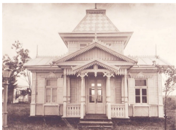
Рис. 2. Здание генеральской ставки в станице Уманской (Ленинградская) Кубанская обл. Фотография начала XX в. [7]
