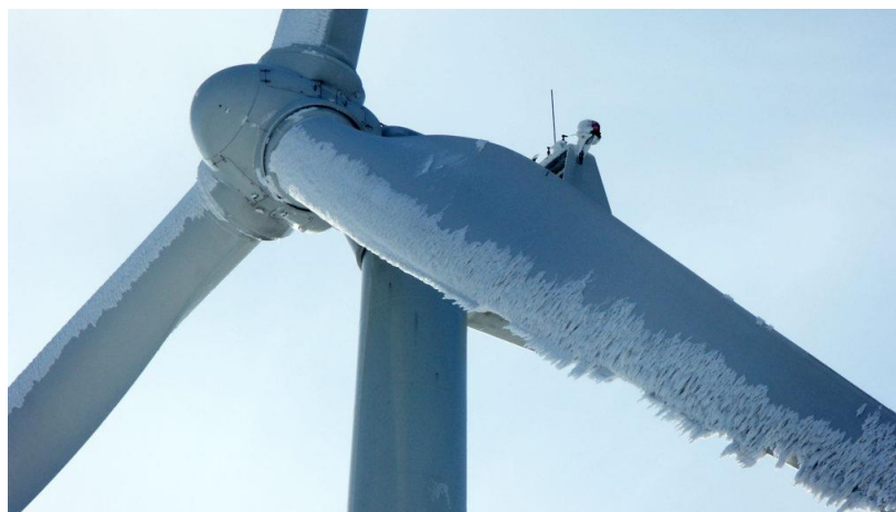
Рисунок 2- Обледеневшие лопасти ветрогенератора.
