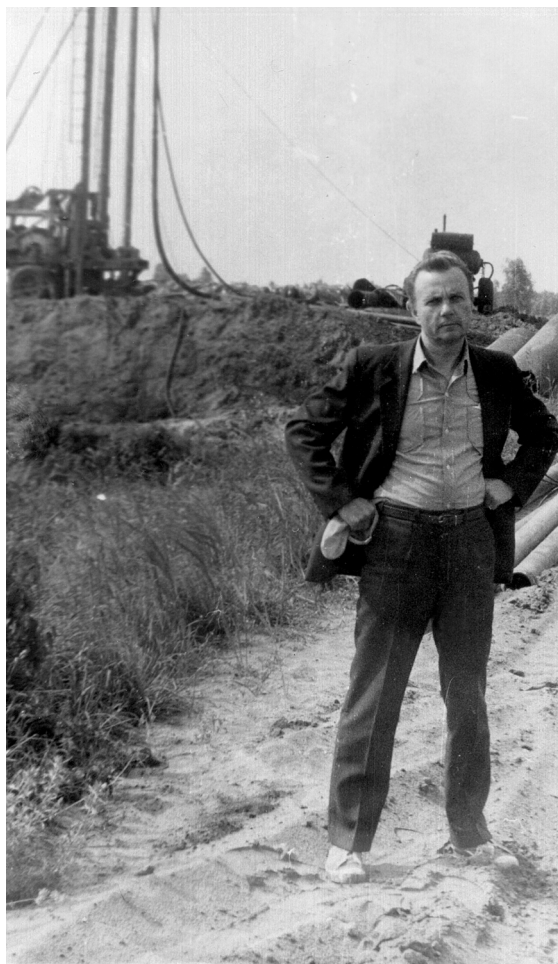
Рис. 1.12. Митрахович А. И. осуществляет контроль за устройством дренажной скважины
