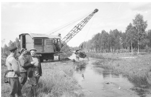
Рис. 1.6. Углубление канала экскаватором-драглайном в 1950–60 гг.
