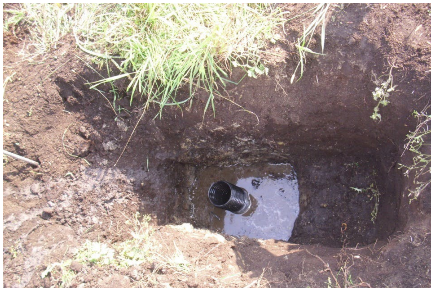
Рис. 6.1. Шурф над одиночной дренажной трубой для определения водоприемной способности труб в полевых условиях. Объект Волма, 2012 г.
