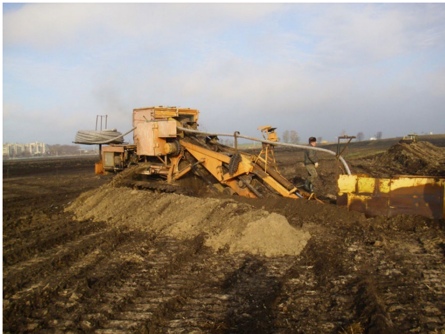
Рис. 4.18. Строительство пластмассового дренажа на объекте Волма, 2011 г.
