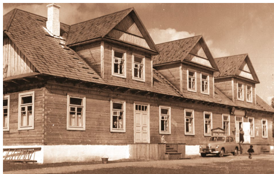
Рис. 1.7. Здание Минской болотной станции
