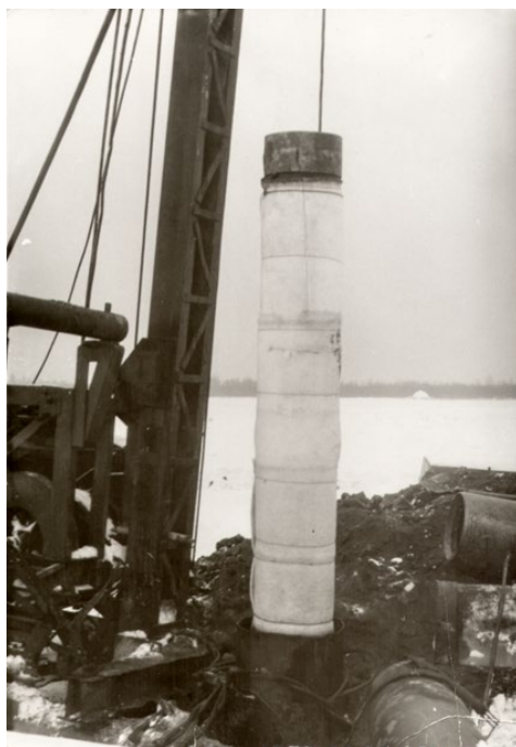
Рис. 1.11. Установка фильтра дренажной скважины на ПОМС
