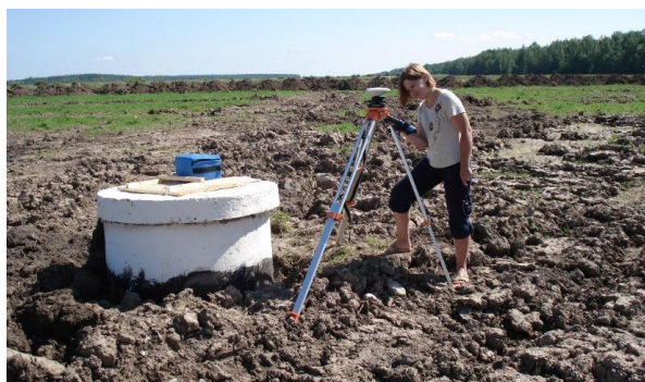
Рис. 5.32. GPS съемку на объекте выполняет Казьмирук И.Ч.
