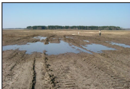
01.10.2008 г. Площадь переувлажнения около 500 м 2 на участке 1
