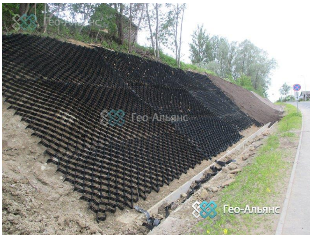
Рисунок 3 – Укрепление откоса георешеткой
