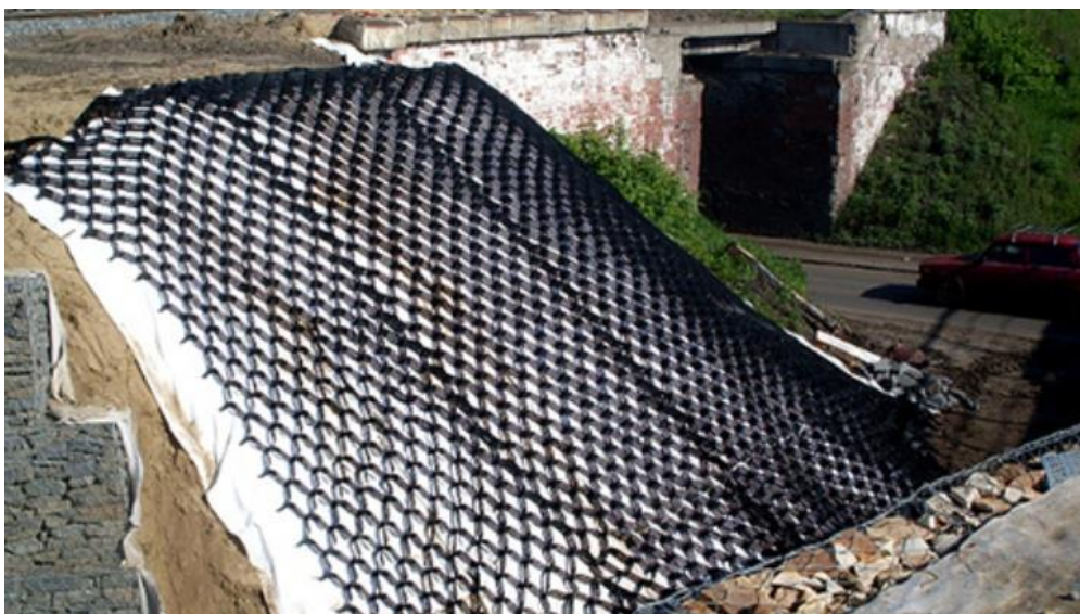
Рисунок 4 – Укрепление откоса с использованием геотекстиля
