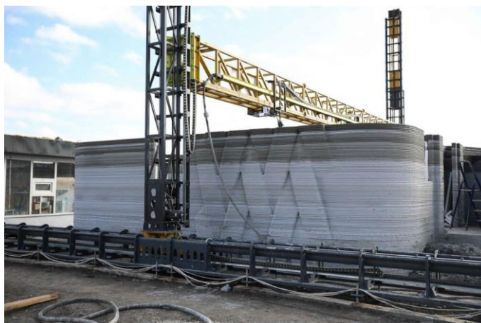
Рисунок 1 – Строительство здания технологией 3D-печати бетона
