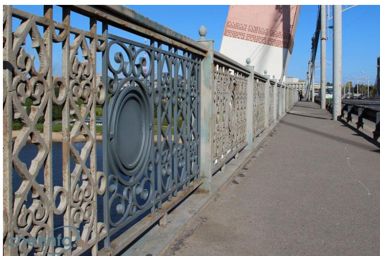
Рисунок 3 – Перильные ограждения моста
