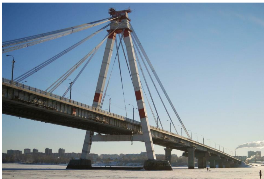
Рисунок 2 – Пилон Октябрьского моста
