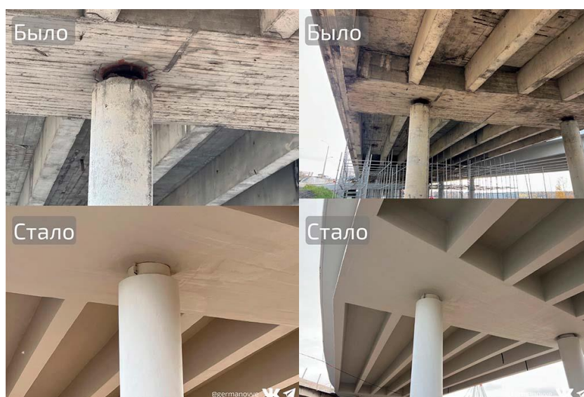
Рисунок 4 – Октябрьский мост до и после реконструкции
