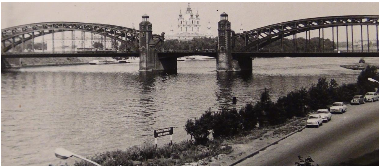
Рисунок 1 – Большоеохтинский мост в 1911 г
