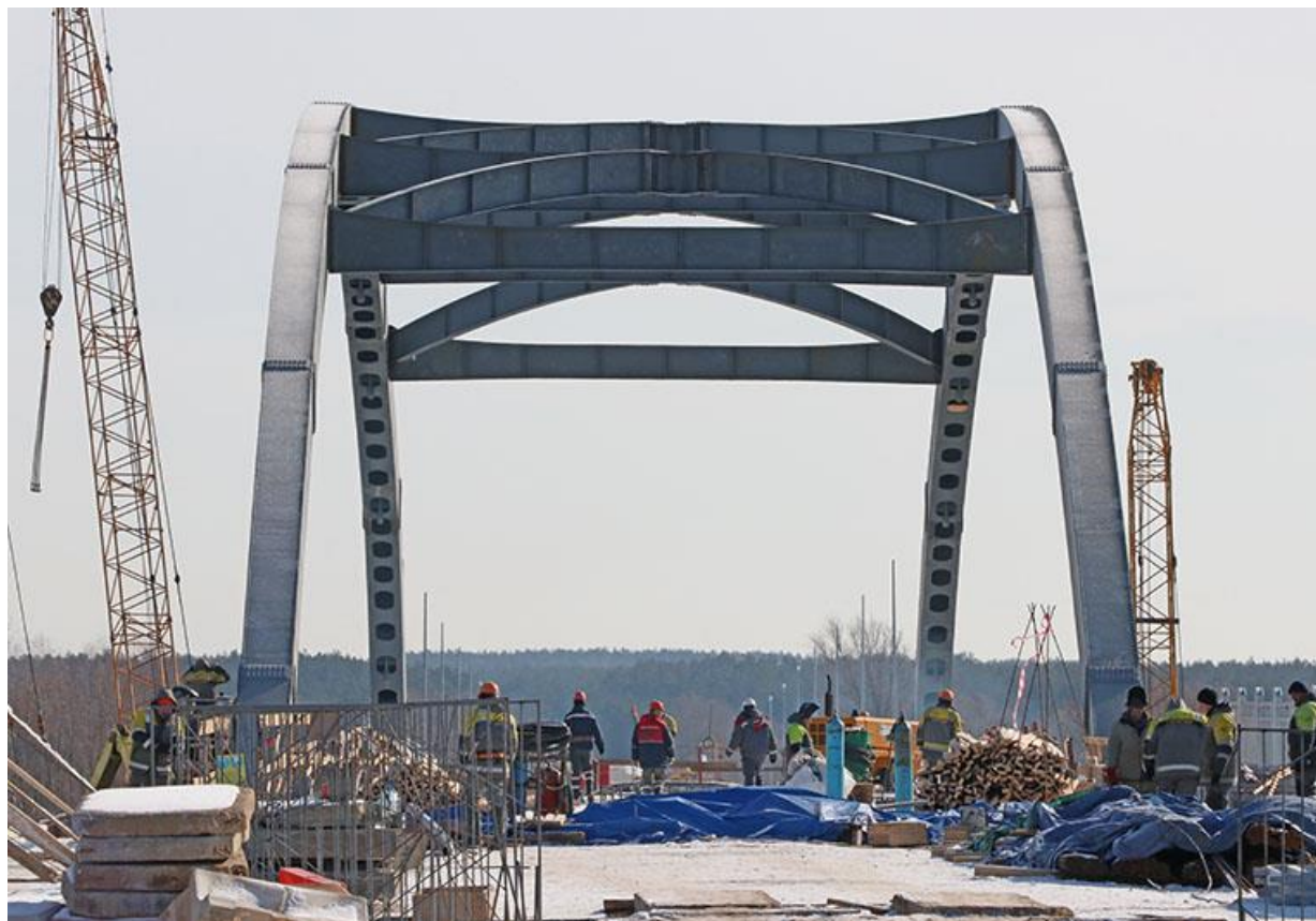
Рисунок 2 – мост через реку Днепр во время строительства
