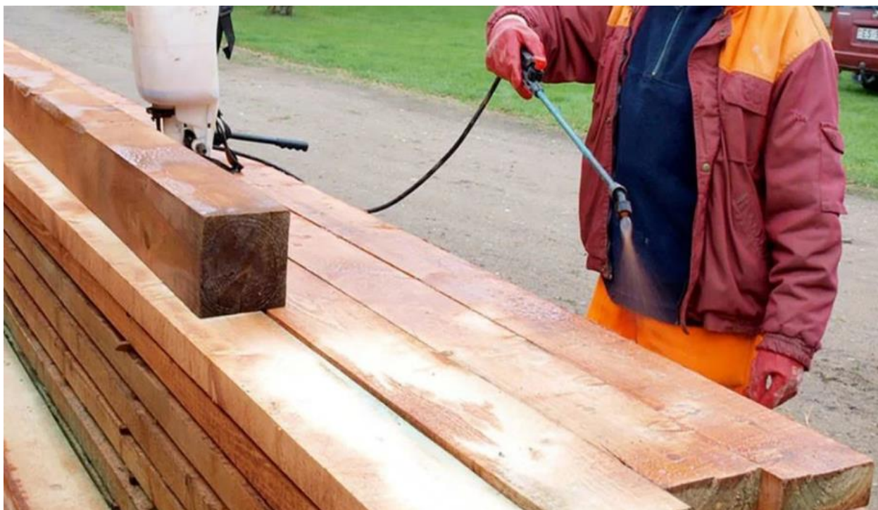
Рисунок 2 – Обработка деревянных балок моста антисептиком
