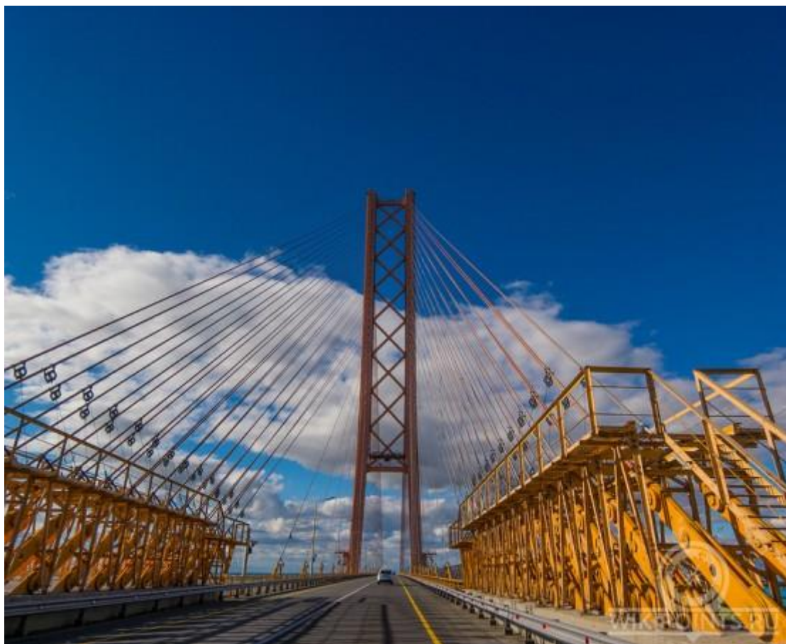
Рисунок 2 – Вид на главный пилон моста и вантовую систему
