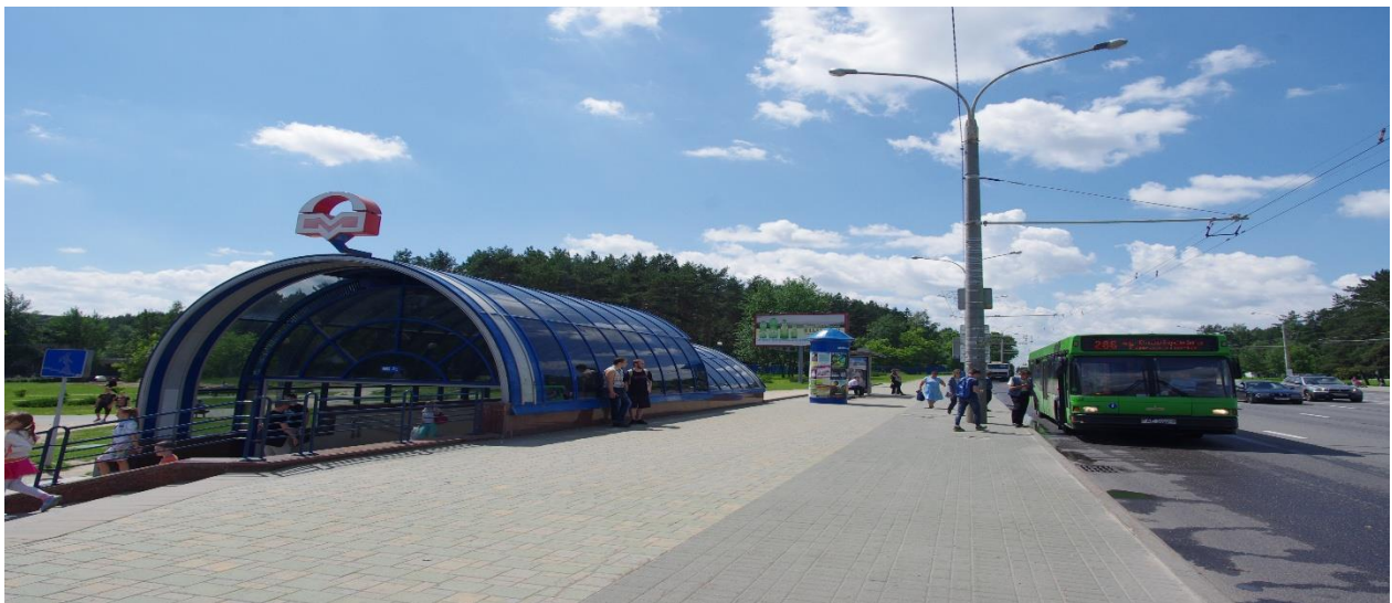
Рисунок 2 – станция метро Борисовский тракт снаружи
