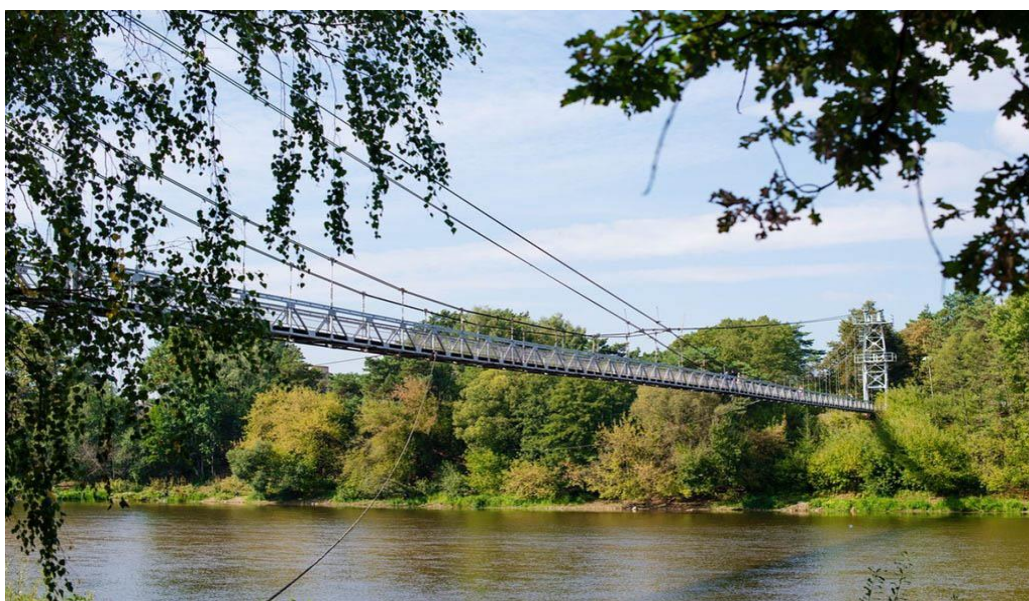
Рисунок 1 – Подвесной мост до реконструкции
