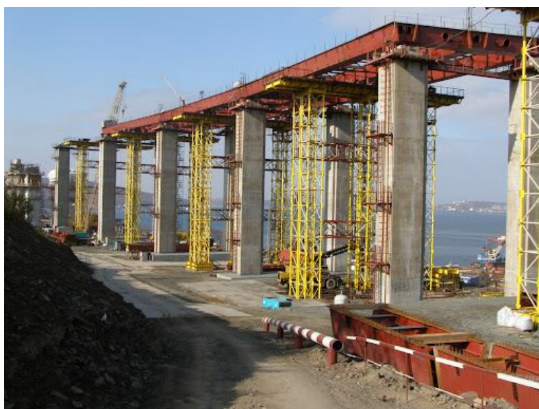
Рисунок 4 – Укрепленный фундамент транспортного сооружения
