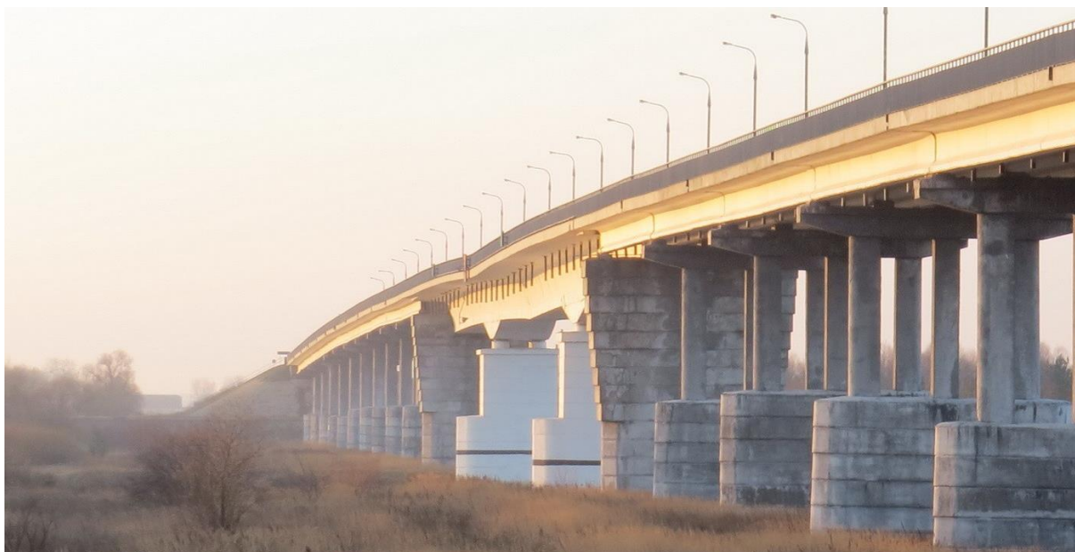
Рисунок 1 – Мост до реконструкции
