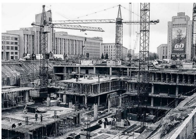
Рисунок 2 – Подготовка котлована к постройке ТЦ «Столица»
