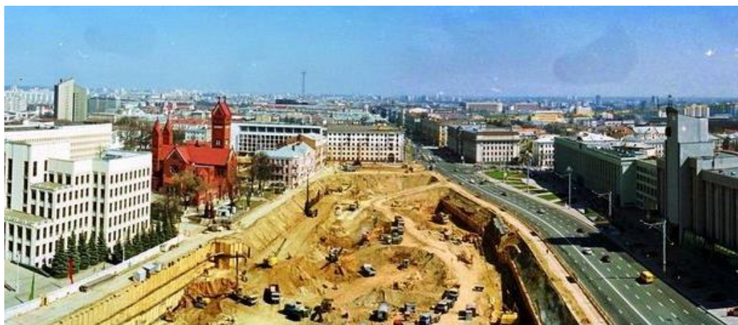
Рисунок 1 – Подготовка котлована к постройке ТЦ «Столица»
