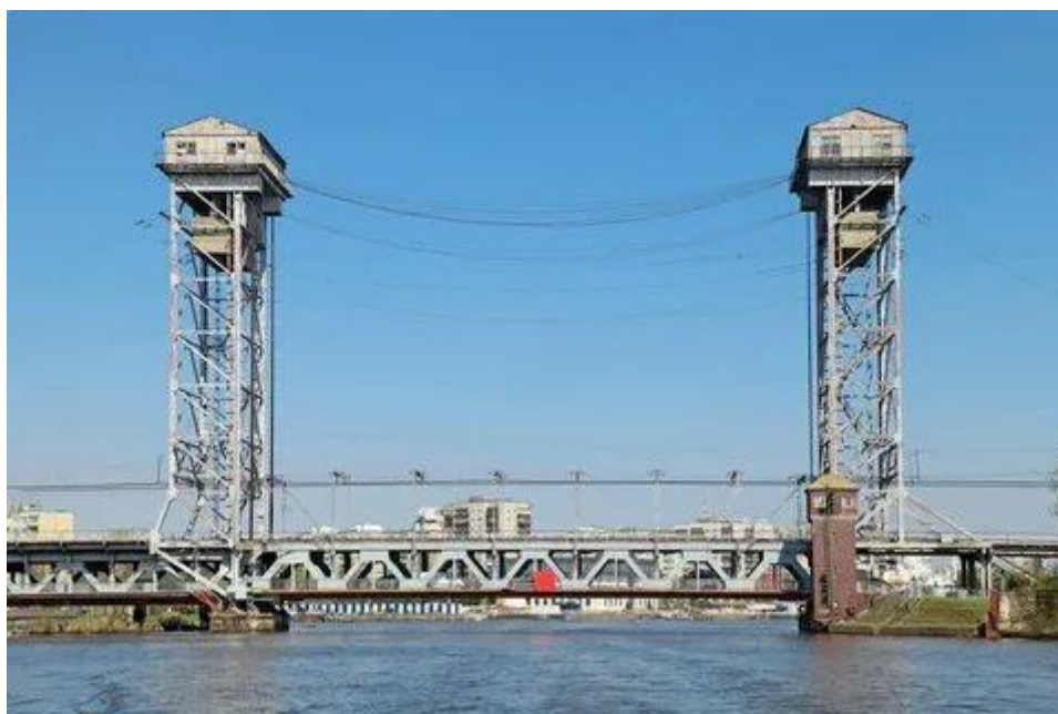
Рисунок 1 – Двухъярусный разводной мост в Калининграде
