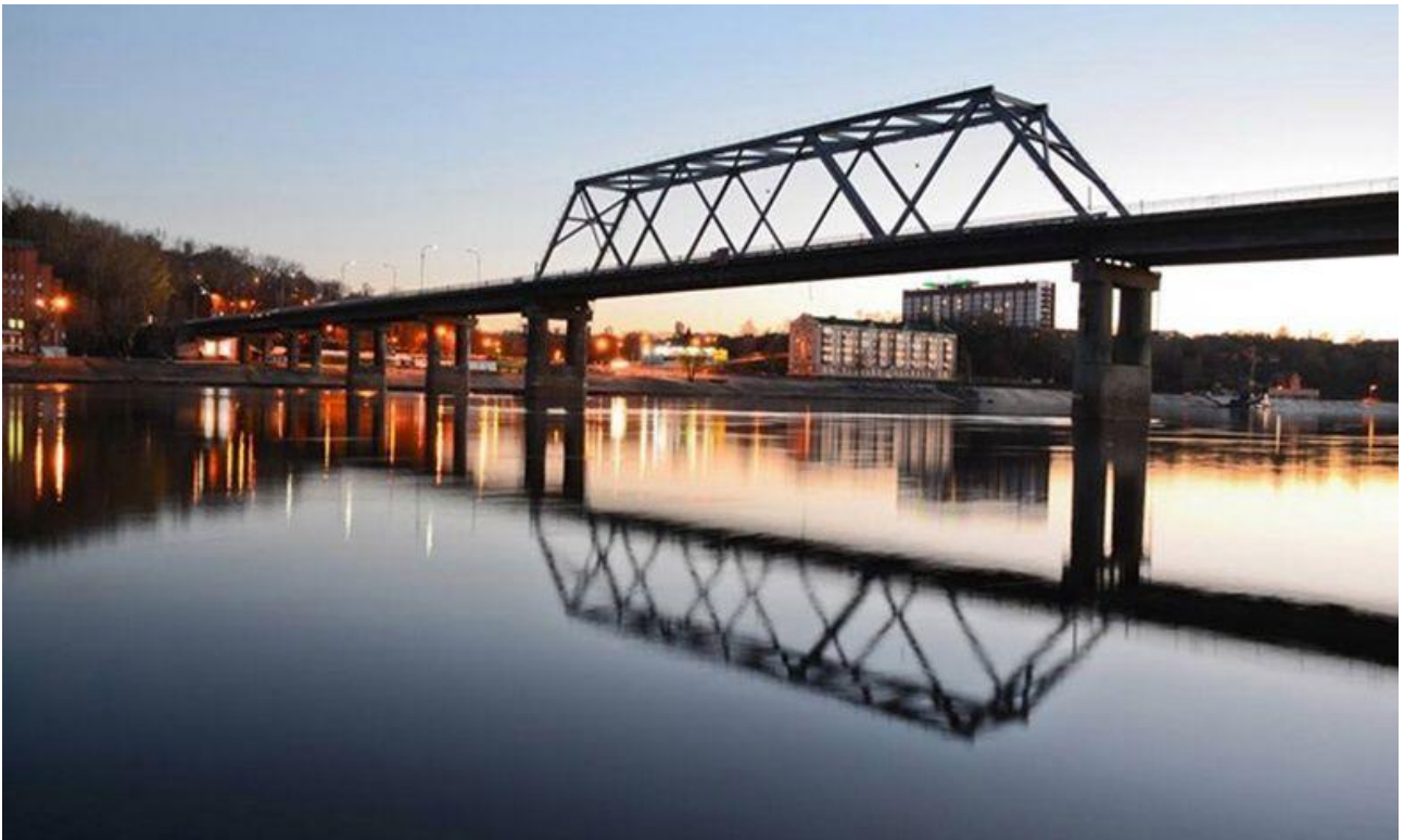
Рисунок 2 – Мост до реконструкции
