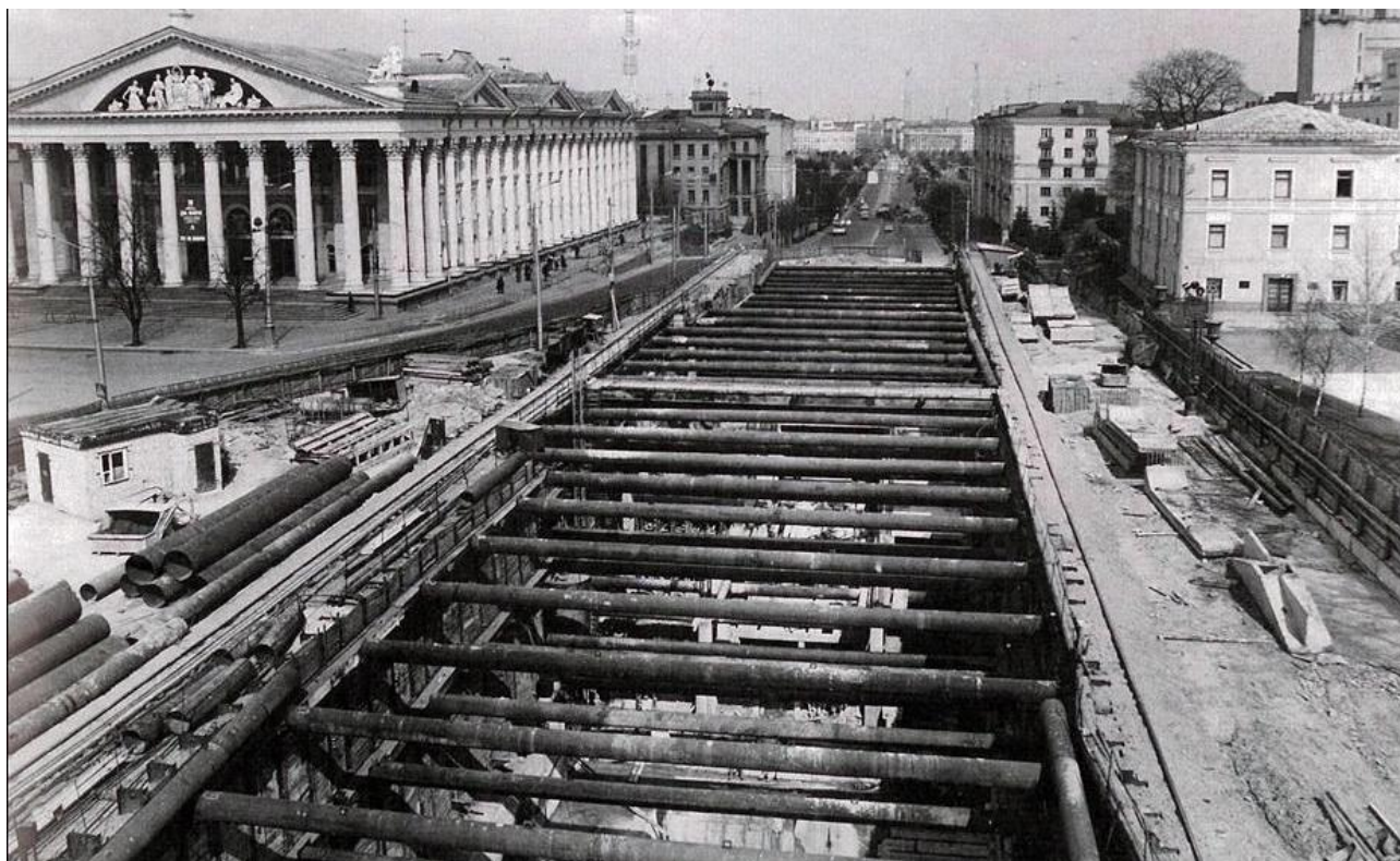
Рисунок 1 – Строительство станции метро Октябрьская
