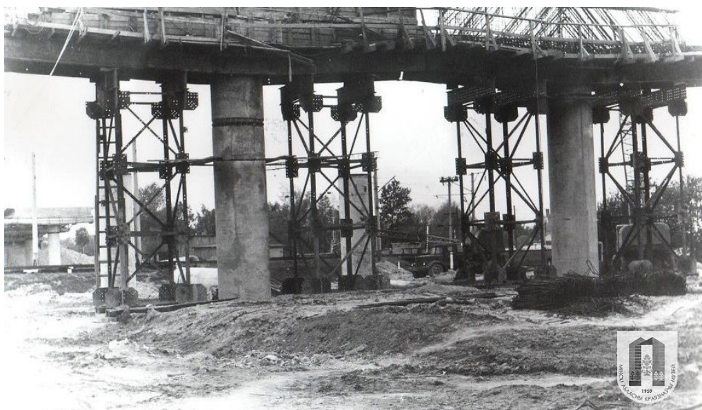
Рисунок 2 – Промежуточные опоры путепроводы большой высоты
