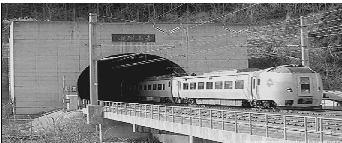
Рисунок 1 – Поезд у портала тоннеля Сэйкан в 1988 г
