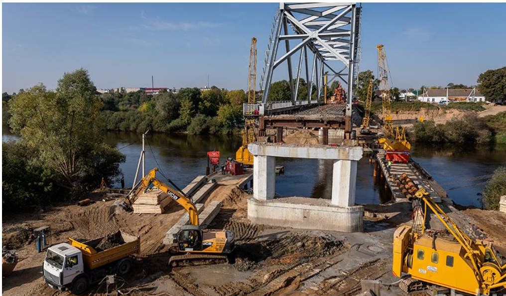
Рисунок 2 – Промежуточные опоры моста
