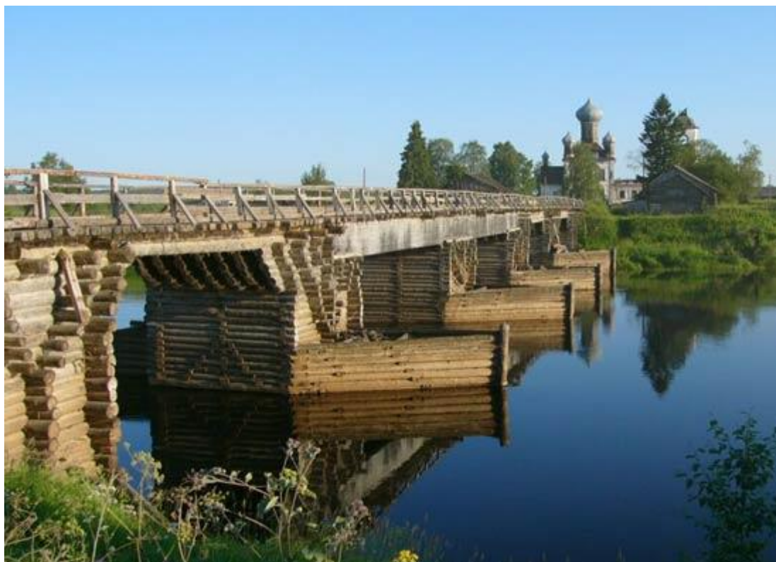
Рисунок 1 – Изображение деревянного моста
