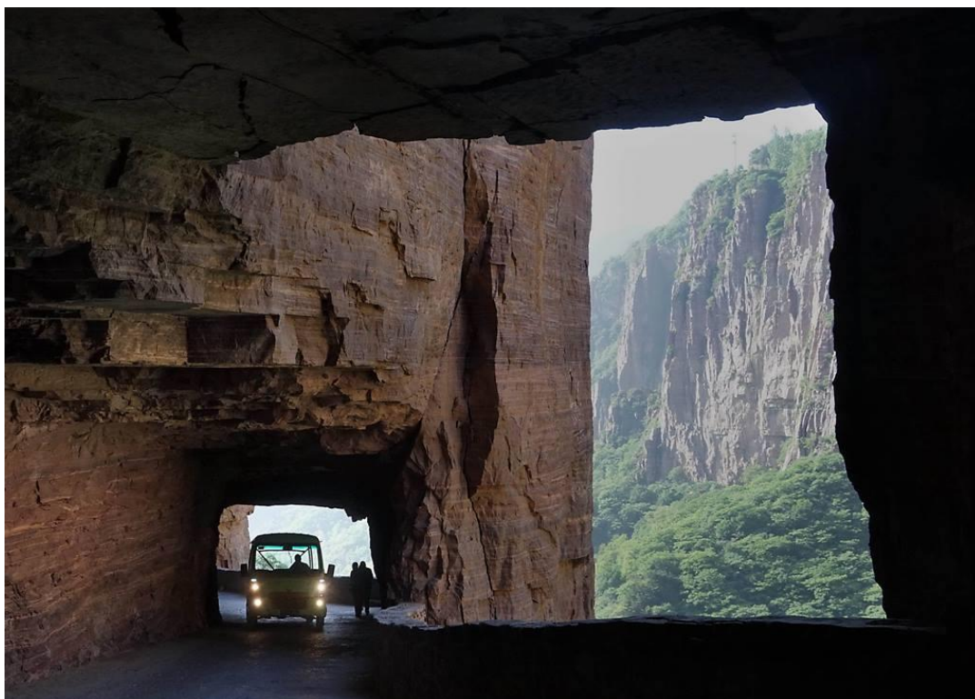
Рисунок 2 – Окна в тоннеле Гуолян, вид на ущелье
