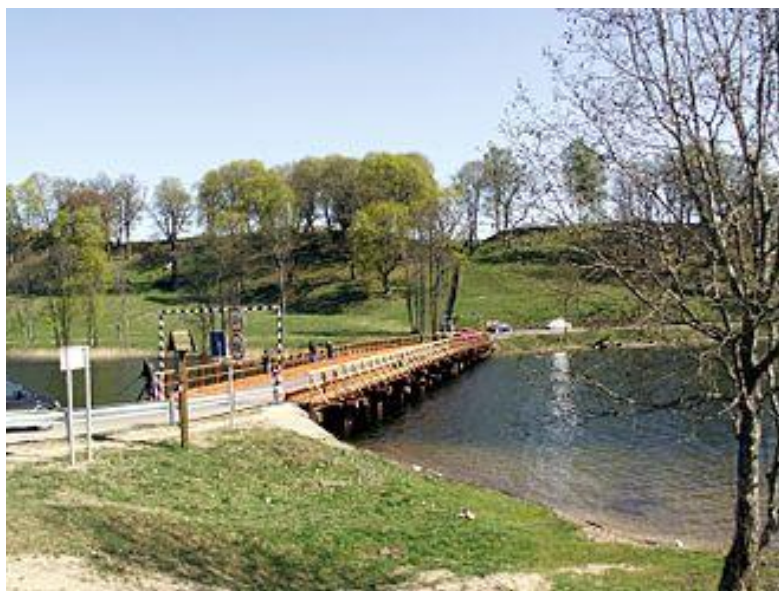
Рисунок 1 – Балочный деревянный мост
