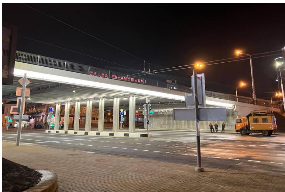
Рисунок 3 – Путепровод после реконструкции в 2022 году
