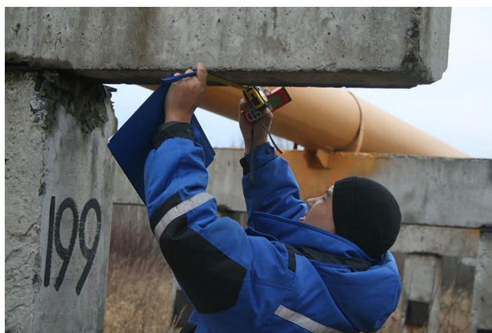
Рисунок 1 – Визуальный осмотр моста
