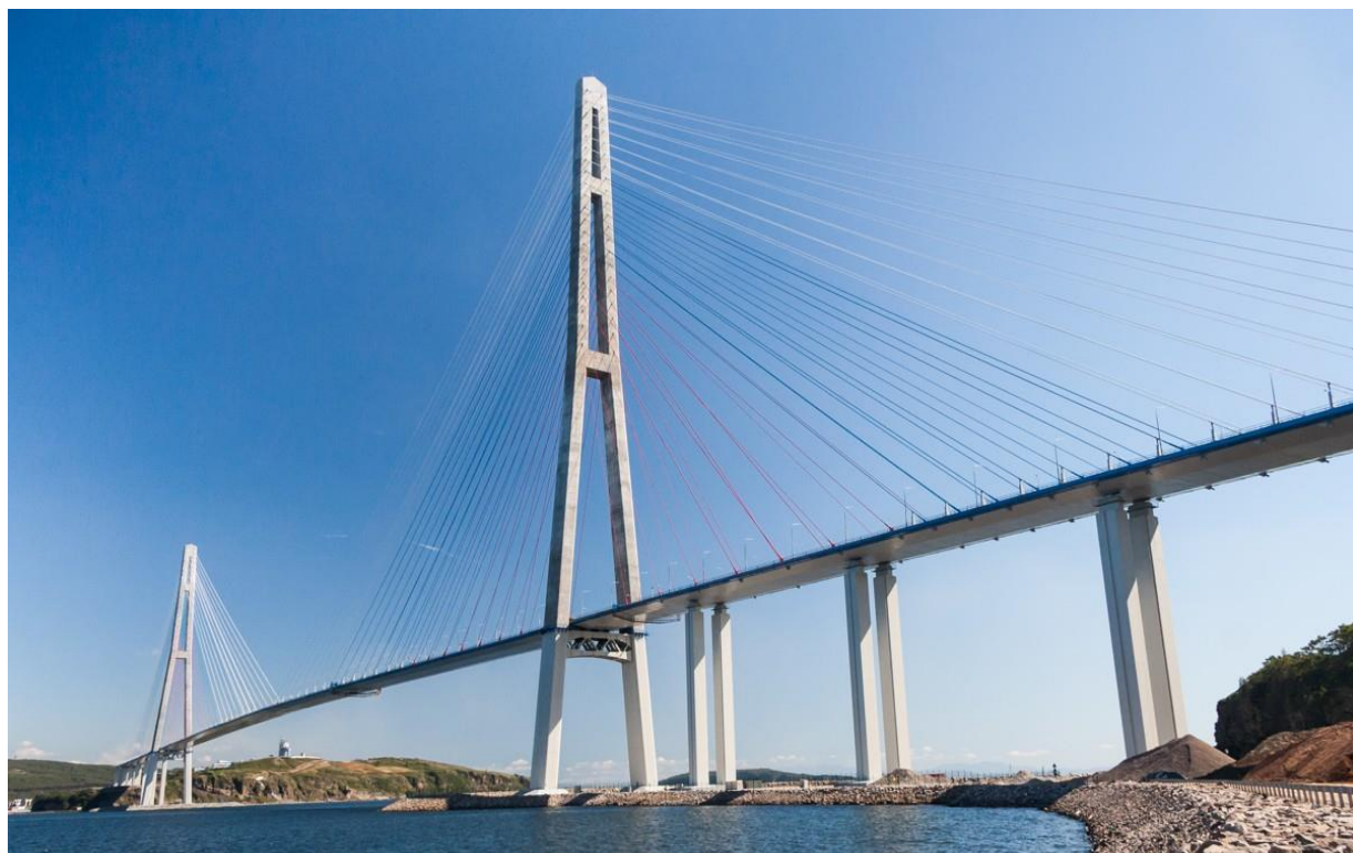
Рисунок 1 – Мост на остров Русский
