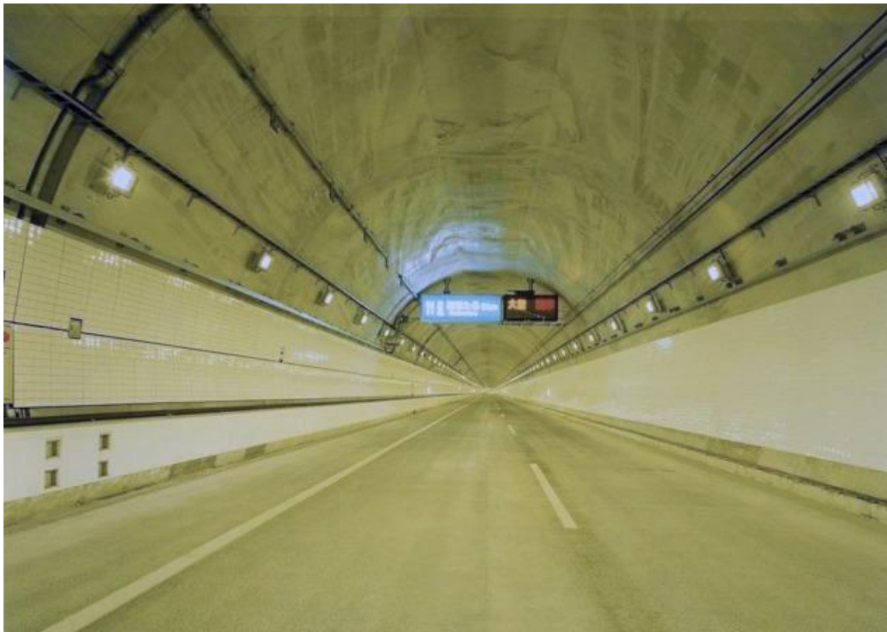
Рисунок 2 – Вид внутри тоннеля
